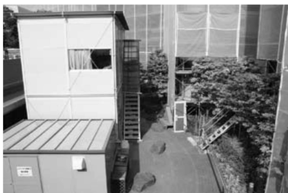
中庭スペースに仮設事務所を設置
